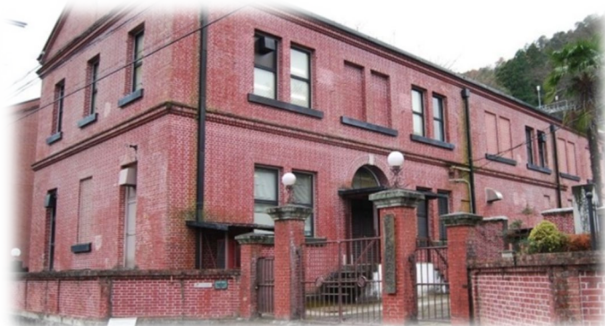
長良川水力発電所本館【岐阜県美濃市】
