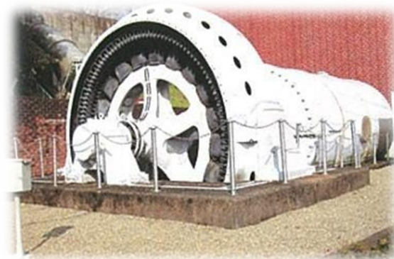
屋外に展示してある水車・発電機
