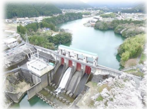
三瀬谷ダム・発電所【多気郡大台町】 (中部電力㈱)
