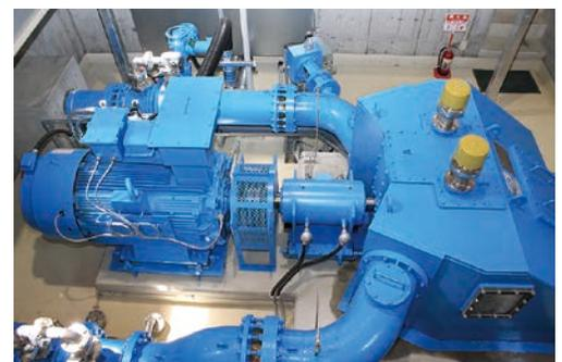
発電機とターゴ水車、水車には上下2つの導水管から注水される
