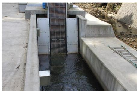
落ち葉などが導水管に流れ込まぬよう、ゲートで濾過する
