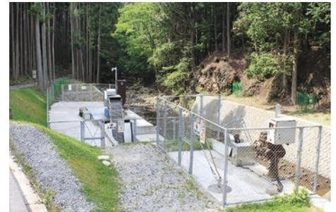
手前の施設が取水口の管理、奥が導水管に続くゲートだ
