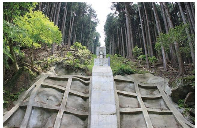
発電所直前の導水管、ここで一気に落差を付けている
