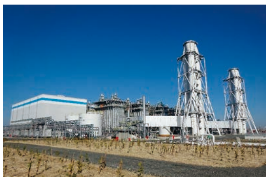
世界最高水準の発電効率を誇る西名古屋火力発電所 写真：(株) JERA 提供
