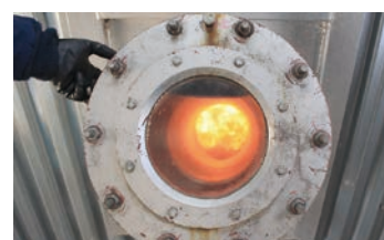
ボイラー内は高温の砂と燃え盛る木質チップが混ざり合っている。
