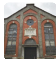
蹴上発電所建屋
