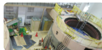
発電機点検の状況
