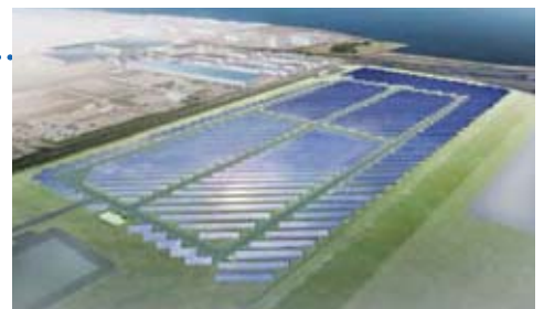
■ 浮島太陽光発電所
