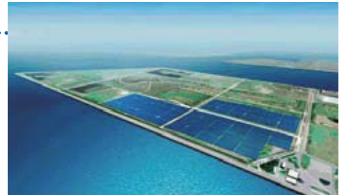
■ 堺第7-3区太陽光発電所
