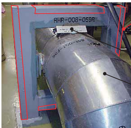
■ 配管サポート改造工事
