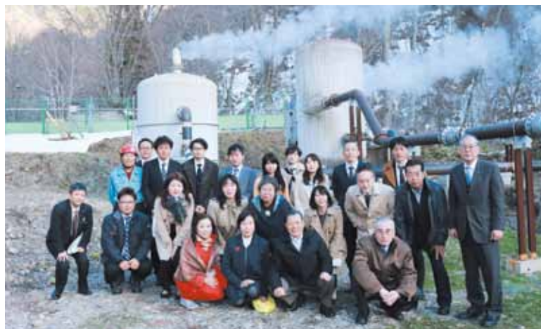
中尾地熱発電建設現場にて(第一生産井)
