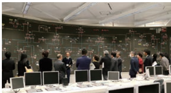
中部電力(株)基幹給電制御所
