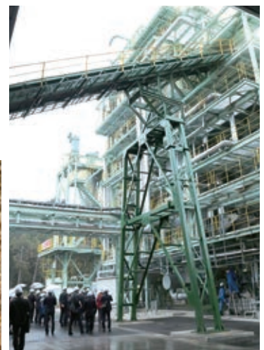
霧島木質発電所
