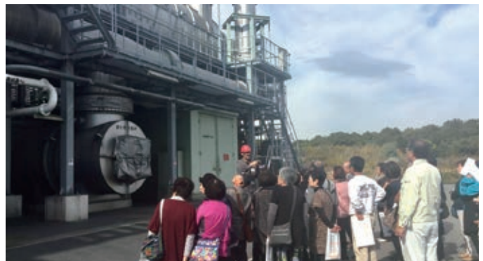
下水汚泥燃料化施設
