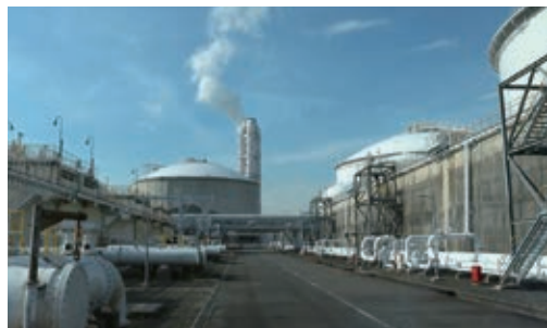
中部電力(株)川越火力発電所
