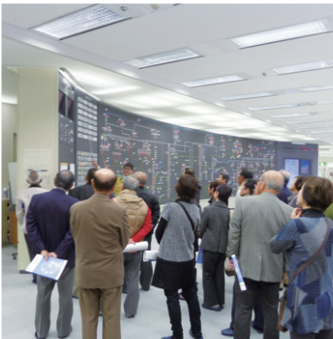
■中部電力(株) 名古屋給電制御所
