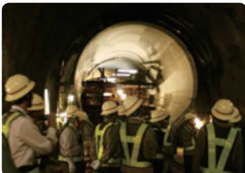
■ 水圧鉄管路。内径5.4m。
