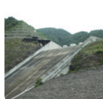
■ 徳山ダム。総貯水容量・堤体積日本一のロックフィルダム。
