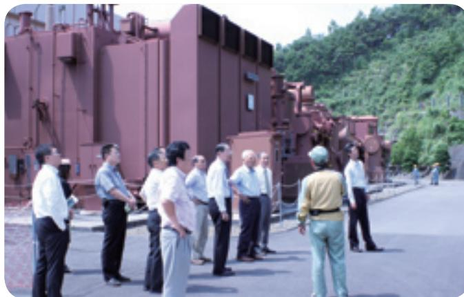
■変圧器 高い電圧を各設備にあわせた低い電圧に変えるための装置です。
