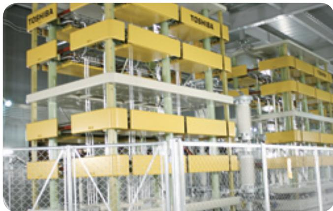
■サイリスタバルブ 交流を直流に変換したり、直流を交流に変換する装置です。
