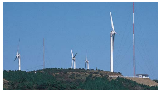
■ 青山高原の風力発電施設
